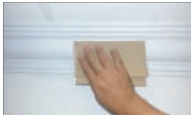
8 - Carteggiare per rendere la superficie liscia e pronta da tinteggiare
