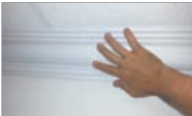
7 - Avvicinare le cornici fino ad unirle ed eliminare il collante in eccesso
