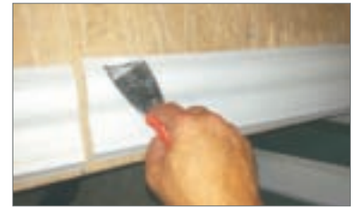
3 - Oppure applicare la colla Get - Kol con spatolina
