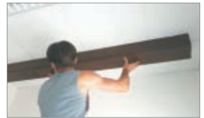
Posizionare la trave al soffitto
