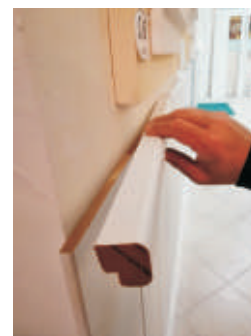
Una volta posate le Doghe, posizionare i FINALI con Colla Ms180
