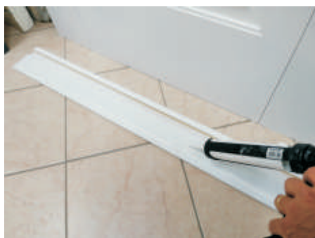
Applicare la Colla Ms180 sul retro del Battiscopa
