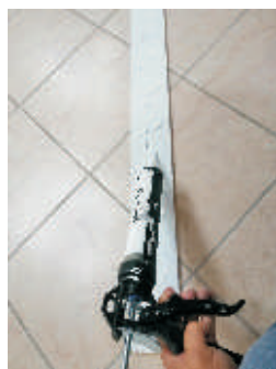
Una volta tagliata la Doga alla misura stabilita, applicare la Colla Ms180 sul retro
