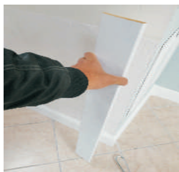
Posizionare la Doga sopra il Battiscopa facendo aderire e seguire una dopo l'altra
