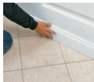
Posizionare il Battiscopa facendo pressione
