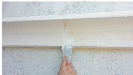
8- Utilizzare la Graniglia per eseguire le stuccature dei giunti e dei finali laterali
