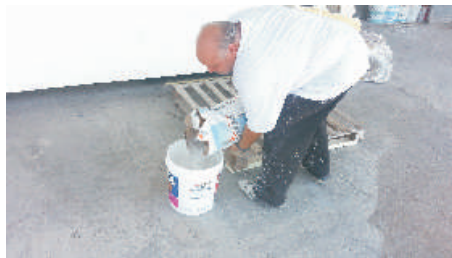
1- Prendere il Collante Bonding e svuotarlo in un secchio da Kg.25
