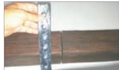
6 - Coprire le giunzioni con apposita staffa decorativa effetto ferro battuto
