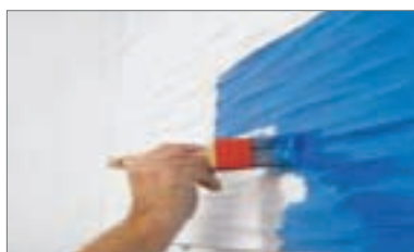
8 - Tinteggiare con idropitture lavabili
