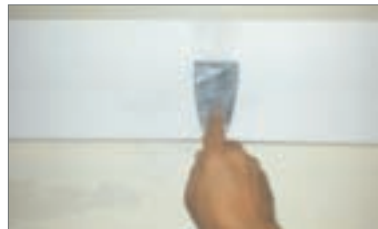
8 - Stuccare il giunto con spatolina
