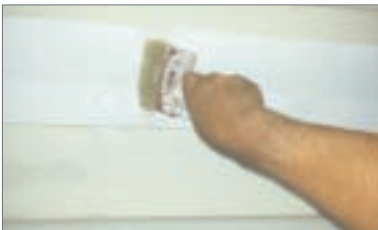
10 - Tinteggiare con pitture lavabili
