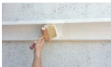
17 - Eseguendo due mani di pittura
