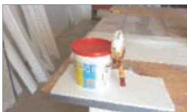
16 - Verniciare con pittura elastomerica
