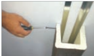
5 - Fissare la trave alle guide con viti autofilettanti
