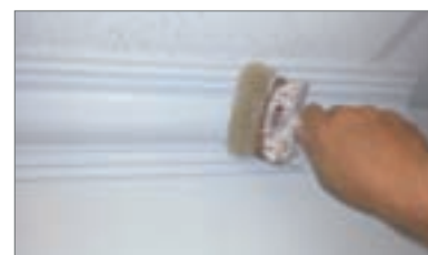
9 - Tinteggiare con pitture lavabili
