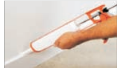
6 - Sigillare eventuali spazi tra muro e cornici per un risultato migliore
