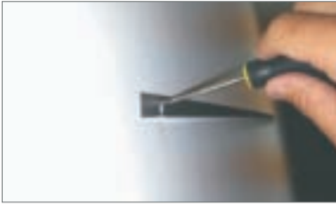
1 - Fissare la guida in alluminio sulla parete all'altezza stabilita e posta a livella
