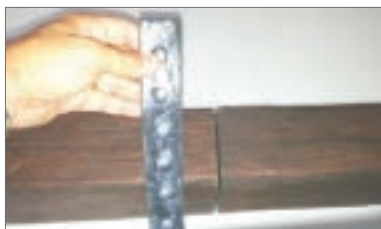
Coprire le giunzioni con apposita staffa decorativa effetto ferro battuto
