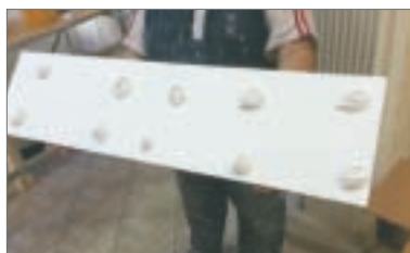
2 - Incollare con sistema a toppe
